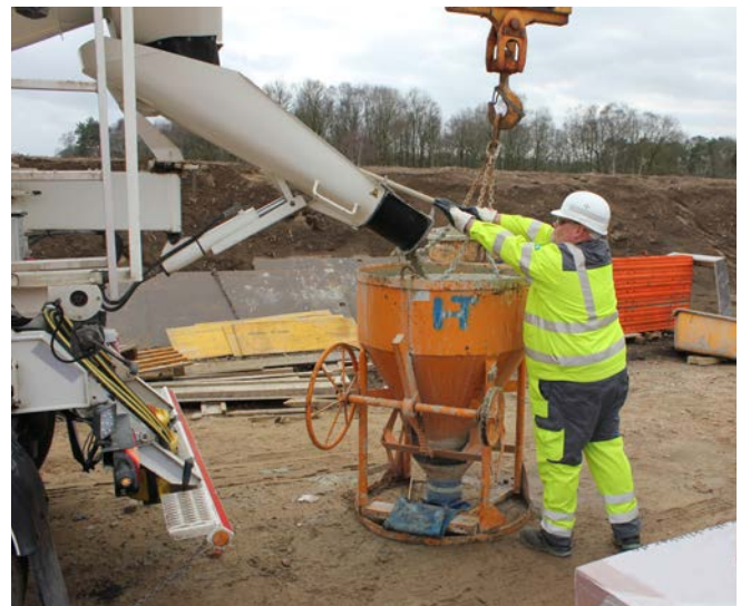
Abb. 19 Befüllung des Betonkübels
