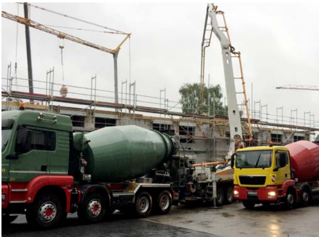
Abb. 20 Betonieren auf der Baustelle mit verschiedenen Arbeitsmitteln
