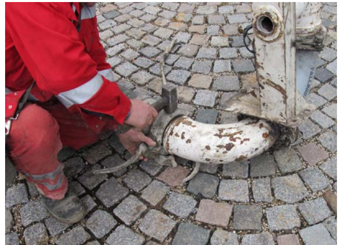
Abb. 33 Lärmeinwirkung beim Lösen einer Rohrkupplung mit Fäustel
