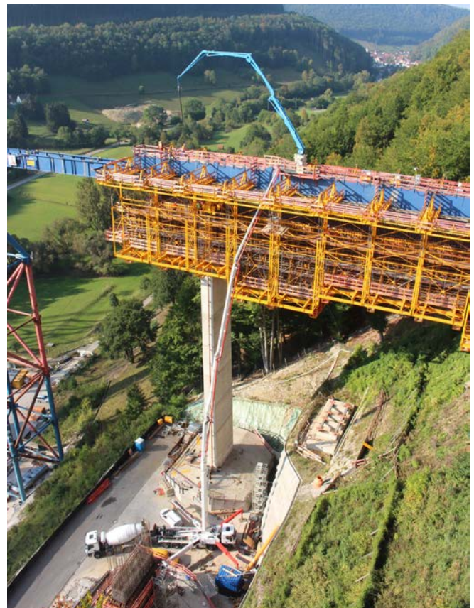
Abb. 1 Brückenbaustelle mit Betonpumpeneinsatz und Frischbetonversorgung durch Fahrmischer
