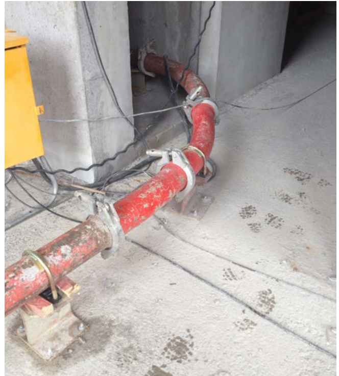
Abb. 35 Rohrbefestigung für den Betoniervorgang
