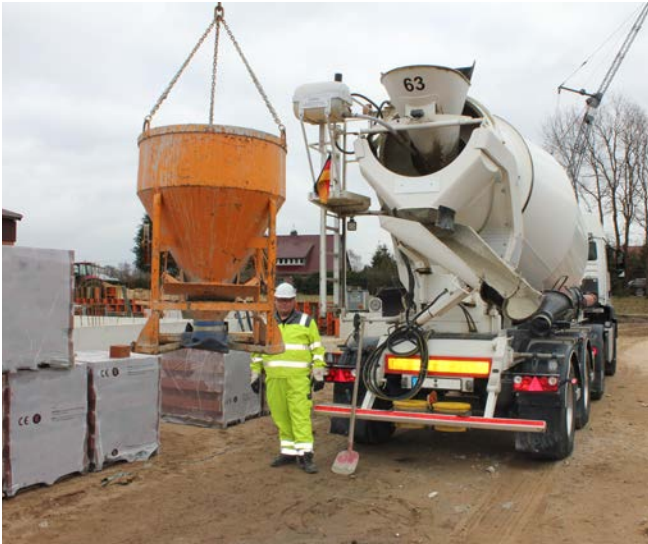
Abb. 18 Betonkübel am Baustellenkran
