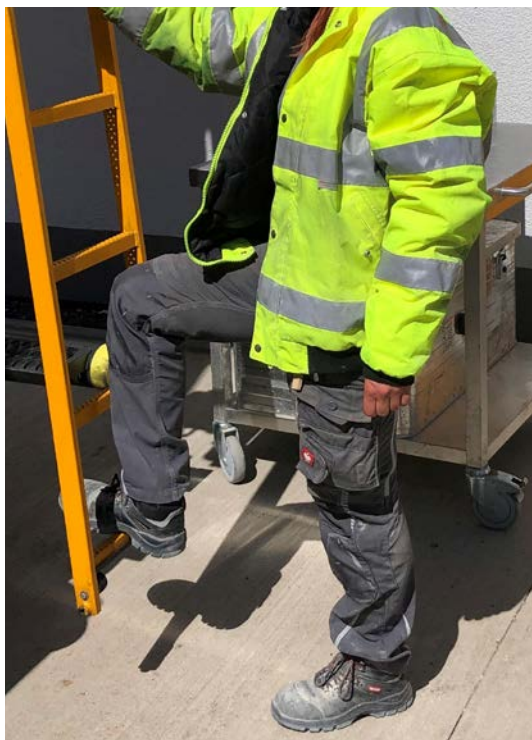
Abb. 10 Unterste Sprosse der Aufstiegsleiter vom Boden aus gut erreichbar.
